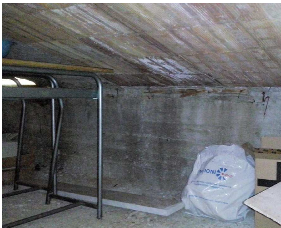
Copertura dell'edificio con struttura in c.a.
