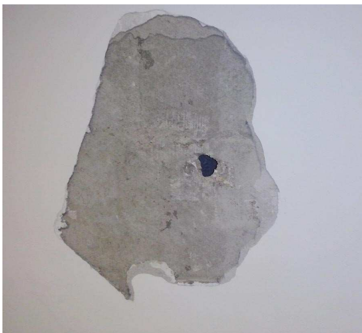
Tipologia muratura esistente (muri di spina interni)
